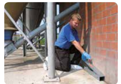
Im Außenbereich werden 70 cm lange, verzinkte und mit einem Gummiboden ausgestattete Köderboxen verwendet.
