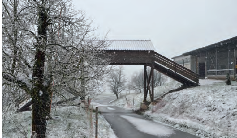
Im Sommer nutzen die Legehennen die Brücke um auf ihre Freilandflächen zu gelangen.
