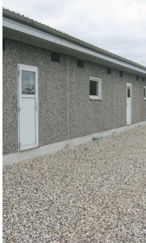
Ein Kiesbett schützt vor Schadnagerbefall, da Schadnager nicht gerne darauf laufen und auch keine Gänge graben können.
