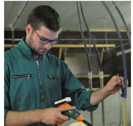
Mit Hilfe eines Endoskops können die Leitungen kontrolliert und ein vorhandener Biofilm sichtbar gemacht werden.
