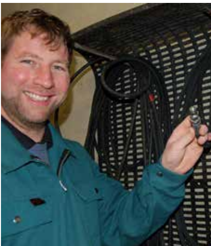
Für die Reinigung der Fallrohre verwendet Evert Hermeling eine Spülmaus.
