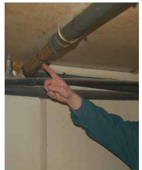
Das Klarsichtrohr dient zur Sichtkontrolle der Futterleitung. Nach der Reinigung muss es klar sein.
