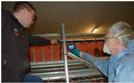
Jannik Pille und Desintec®-Berater Heinz Pruiskens kontrollieren mit Hilfe eines Endoskops die Wasserleitungen.
