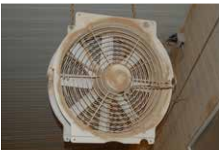
Für ein verbessertes Stallklima wurden Lüfter nachgerüstet.
