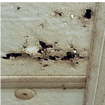
Mäuse verursachen erhebliche Schäden an Dämmmaterialien.
